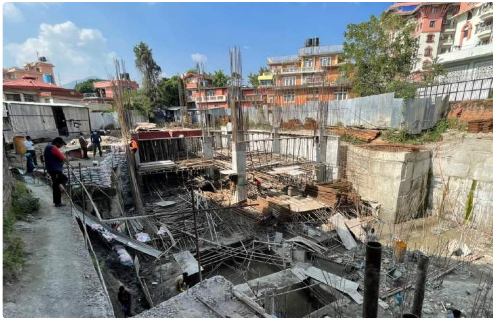
निर्माणाधिन केन्द्रीय कार्यालय भवन, लाजिम्पाट, काठमाडौं (मिति २०७८-०८-०३ गते लिइएको फोटो)
